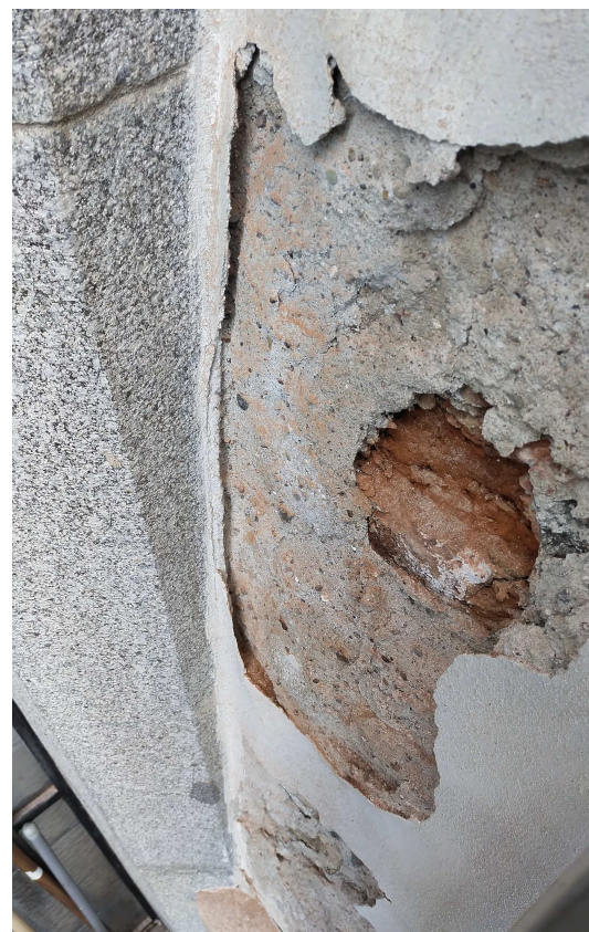
NARUŠENÉ VRSTVY OMÍTEK JIŽNÍHO PILÍŘE
