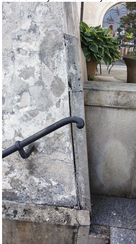
UVOLNĚNÉ OBKLADOVÉ DESKY SOKLU PILÍŘE
