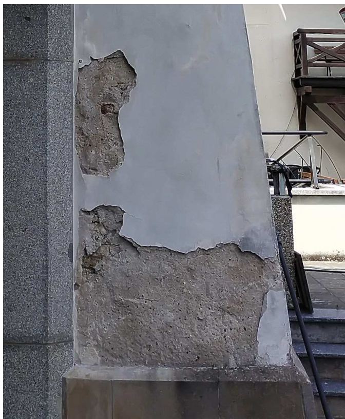
NARUŠENÉ VRSTVY OMÍTEK JIŽNÍHO PILÍŘE
