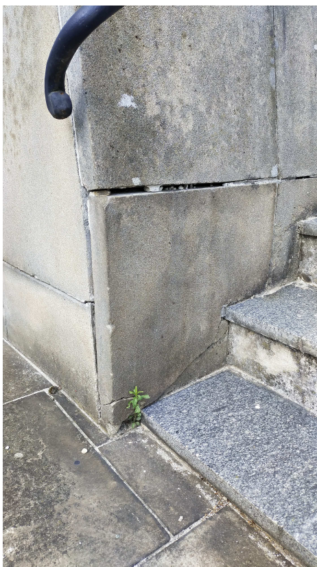
UVOLNĚNÉ OBKLADOVÉ DESKY SOKLU PILÍŘE
